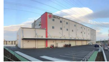
新工場「綾瀬プラント」外観
